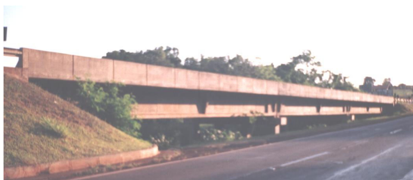
Foto 1. Túnel de passagem do corredor da biodiversidade sob a BR-277 (Santa Terezinha).
